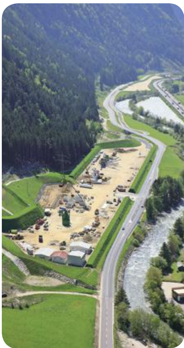
L'area di cantiere di Mules mostra le misure di tutela ambientale.
