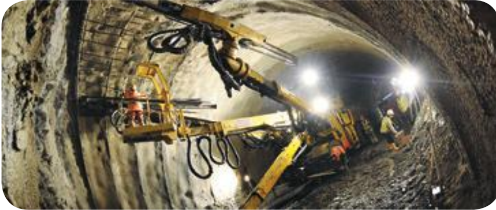
Stabilizzazione della galleria tramite reti di armatura.
