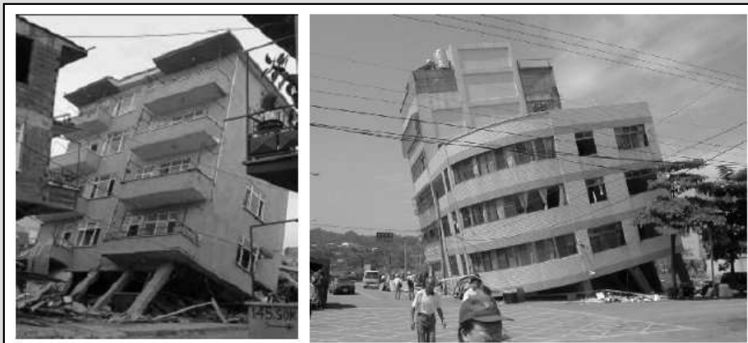
Figura 3: Due crolli tipici degli edifici con "primo piano soffice": a sinistra un edificio di Izmit (Kocaeli Earthquake, Turchia); a destra un edificio di Taipei ("Chi Chi Earthquake, Taiwan")
