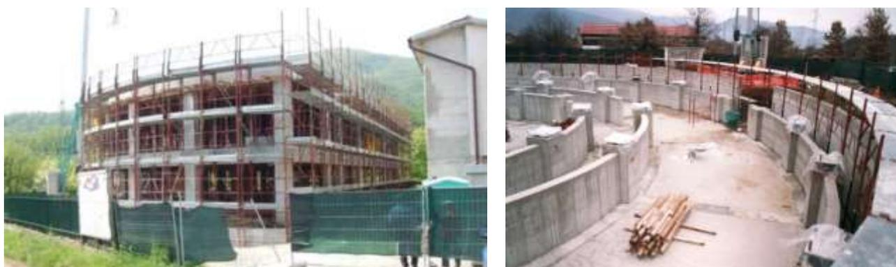
Figura 4 – La nuova scuola di Mulazzo (MS) e vista del sistema d'isolamento sismico durante la costruzione nel 2008. Il collaudo in c.o. è affidato ad A. Martelli per conto dell'ENEA
