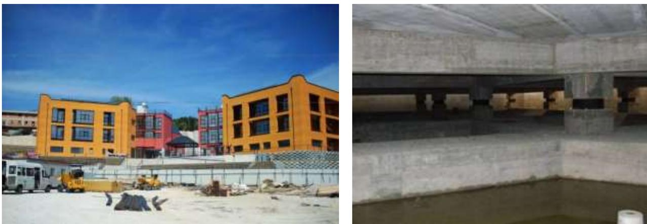
Figura 1 – La nuova scuola Francesco Jovine ed il Centro Professionale ed Universitario "Le Tre Torri" di San Giuliano di Puglia, al momento del collaudo da parte di A. Martelli per conto dell'ENEA in settembre 2008; vista del sistema d'isolamento sismico durante la costruzione
