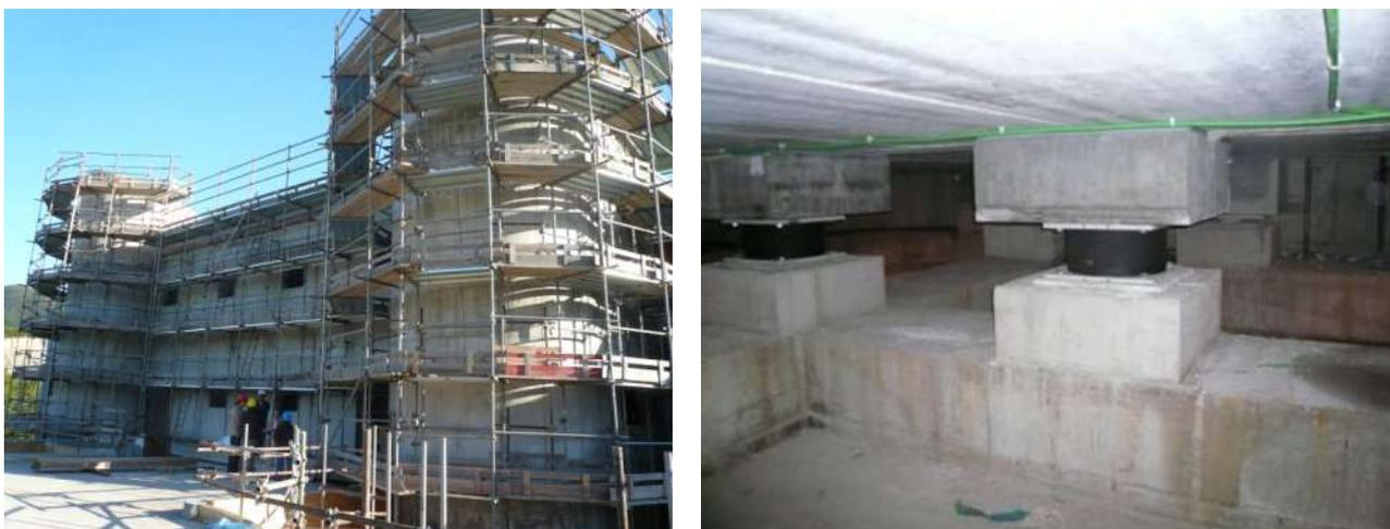
Figura 2 – La nuova scuola di Marzabotto (BO) e vista del sistema d'isolamento sismico, durante la costruzione (ottobre 2009). L'ENEA ha collaborato al progetto dell'isolamento sismico. Il collaudo in c.o. è affidato ad A. Martelli per conto dell'ENEA
