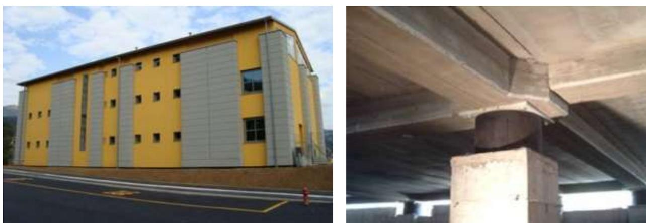
Figura 5 – La nuova scuola di Galliciano (LU), completata in settembre 2009 con l'isolamento sismico nell'ambito di un Protocollo d'Intesa fra Regione Toscana, ENEA e GLIS
