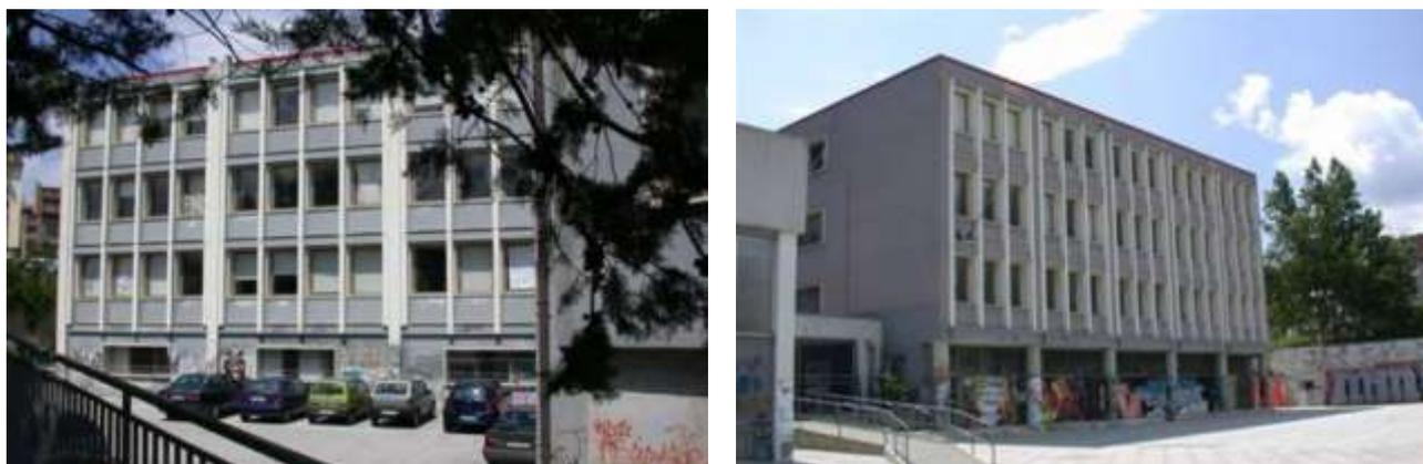
Figura 3 – Il Liceo Scientifico Romita di Campobasso (che ospitava 1.300 studenti), prima della demolizione (di prossimo inizio) e della successiva prevista ricostruzione con l'isolamento sismico di almeno due dei suoi corpi di fabbrica. L'ENEA ha collaborato agli studi di vulnerabilità sismica ed al progetto dell'isolamento sismico. Il collaudo in c.o. è affidato ad A. Martelli per conto dell'ENEA
