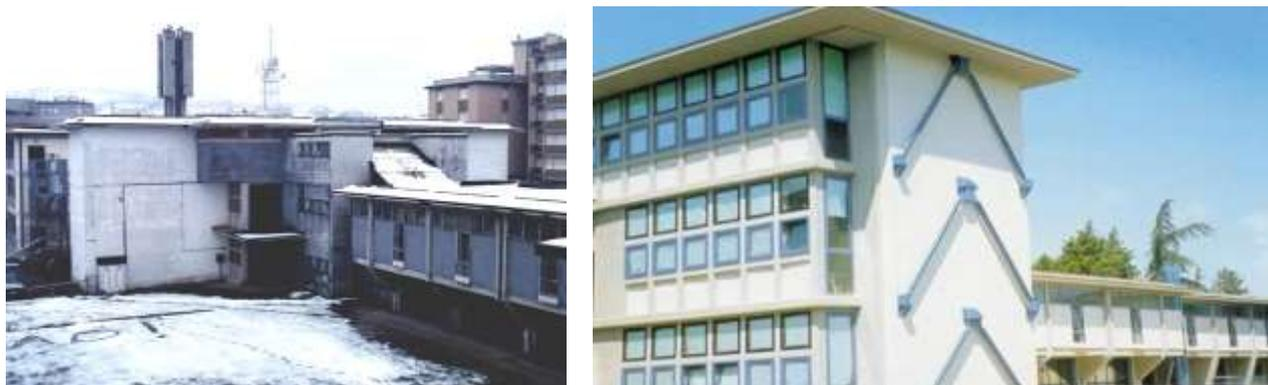
Figura 6 – La scuola Gentile Fermi di Fabriano, prima e dopo il miglioramento sismico con dissipatori viscoelastici sviluppati nell'ambito del progetto comunitario REEDS, effettuato a seguito dei danni subiti durante il terremoto umbro-marchigiano del 1997-98
