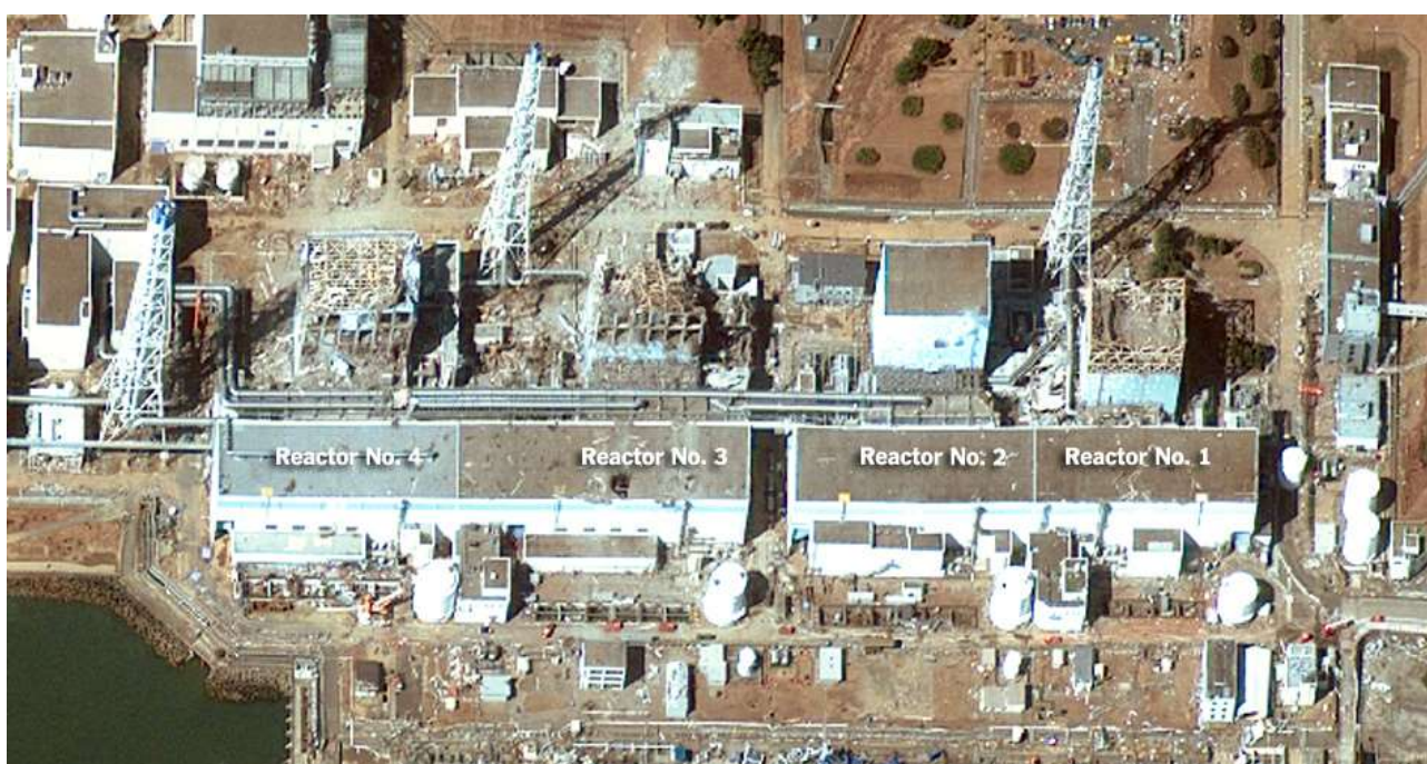
Figura 7 - Gli impianti di Fukushima Daiichi dopo lo tsunami
