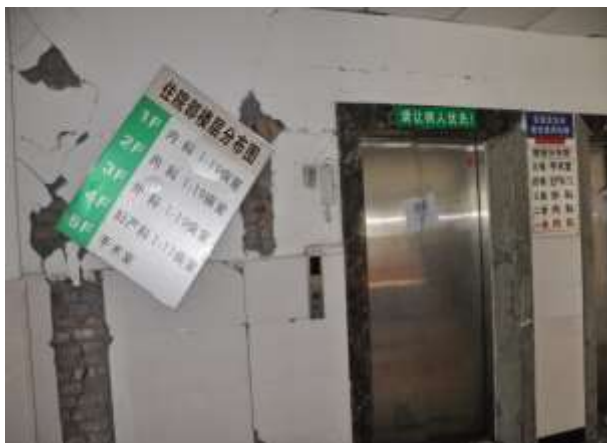
Figure 7 e 8 - Danni causati dal terremoto di Lushan all'interno dei due edifici fondati convenzionalmente dell'ospedale di Figure 2 e 3 [5]
