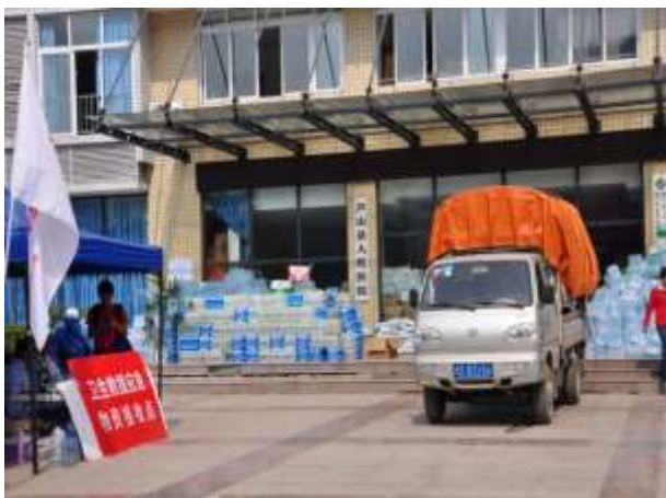
Figura 9 - Assenza di danni, dopo il terremoto di Lushan , alle strutture portanti dell'edificio isolato sismicamente dell'ospedale di Figure 2 e 3 [5]
