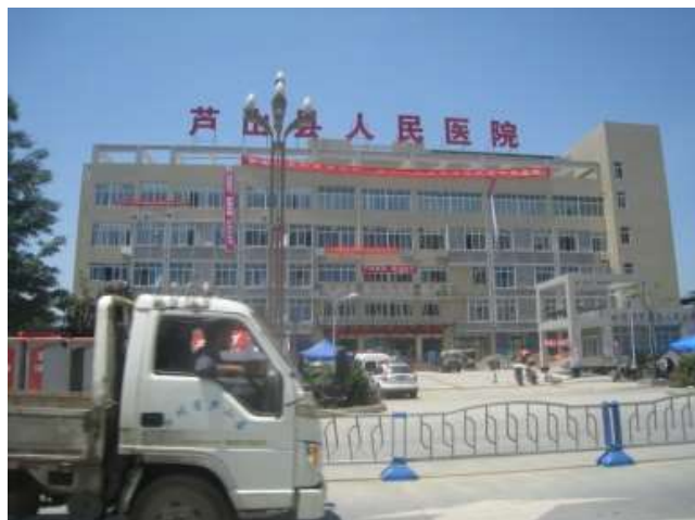
Figura 3 - Vista dell'edificio isolato dell'ospedale di Figura 2, protetto da 83 isolatori in gomma-piombo ( Lead Rubber Bearing o LRB), transennato dopo il terremoto del 20 aprile 2013
