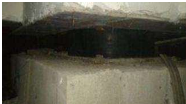
Figura 4 - Isolatori sismici del sistema utilizzato per proteggere d'edificio isolato di Figure 2 e 3
