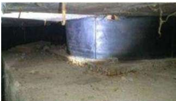
Figura 4 - Isolatori sismici del sistema utilizzato per proteggere d'edificio isolato di Figure 2 e 3
