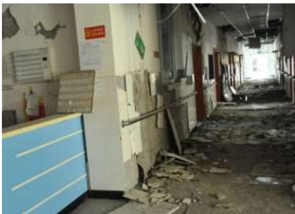
Figure 7 e 8 - Danni causati dal terremoto di Lushan all'interno dei due edifici fondati convenzionalmente dell'ospedale di Figure 2 e 3 [5]
