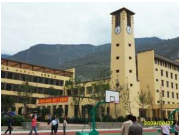
Figura 5 - Una delle due scuole elementari di Lushan, la prima fondata convenzionalmente e l'altra con l'isolamento sismico, colpite dal terremoto del 20 aprile 2013 [5]
