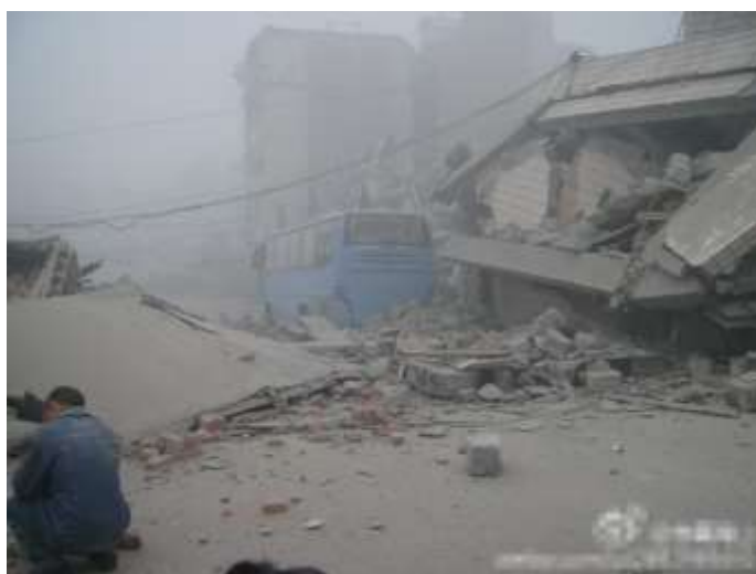
Figura 1 - Distruzioni causate dal terremoto di Lushan (R. P. Cinese) del 20 aprile 2013 [5].
