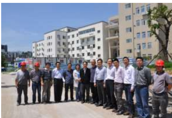
Figura 12 - Vista laterale dell'ospedale di Lushan dopo il terremoto del 20 aprile 2013 (a sinistra sono visibili i danni riportati da uno dei due edifici fondati convenzionalmente, mentre a destra risulta evidente l'integrità di quello isolato sismicamente) [5]
