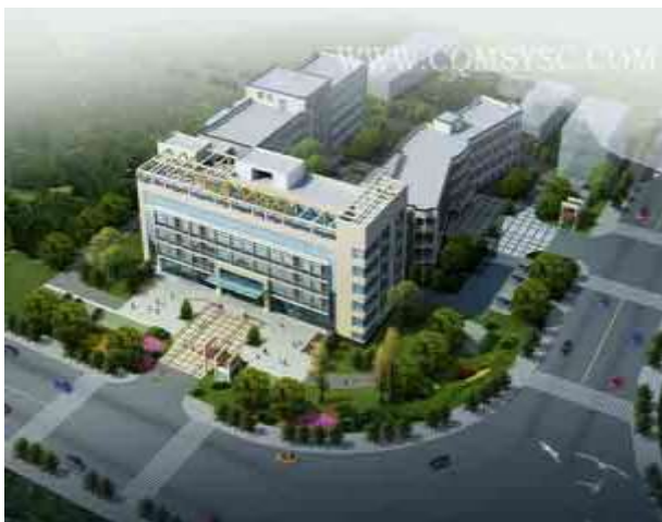
Figura 2 - Vista (prima del terremoto del 20 aprile 2013) dell'ospedale della contea di Lushan, costituito da un edificio isolato simicamente (quello frontale, nella foto) e due fondati convenzionalmente (quelli laterali) [5]
