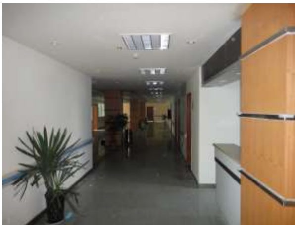
Figura 10 - Assenza di danni, dopo il terremoto di Lushan , all'interno dell'edificio isolato sismicamente dell'ospedale di Figure 2 e 3 [5]
