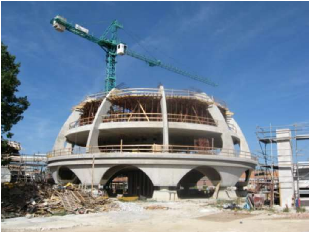
Centro di emergenza della Protezione Civile di Foligno. Edificio isolato alla base (Progetto: Prof. Ing. Alberto Parducci, Dott. Arch. Guido Tommesani)
