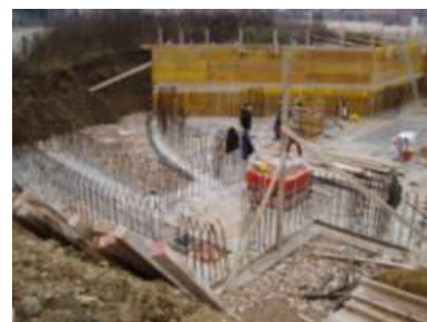
"Sale Operative" del complesso degli edifici isolati alla base della Protezione Civile, in costruzione a Foligno. (Progetto: Prof. Ing. Alberto Parducci, Dott. Arch. Guido Tommesani)
