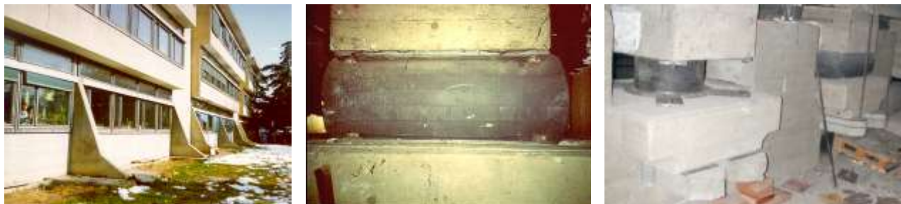
Figura 2: La scuola Johan Heinrich Pestalozzi, costruita a Skopje (Macedonia) negli anni '60 (a sinistra), vista di uno dei LDRB che costituivano sistema d'isolamento sismico originario (al centro) e vista di un nuovo HDRB appena installato nel 2007, a fianco di un LDRB non ancora sostituito (a destra)
