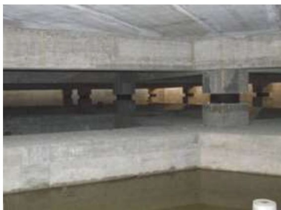
Figura 3: La nuova scuola Francesco Jovine ed il Centro Professionale ed Universitario "Le Tre Torri" di San Giuliano di Puglia, eretti su un'unica piastra isolata sismicamente, al momento dell'inaugurazione il 18 settembre 2008 (a sinistra), e vista del sistema d'isolamento sismico durante la costruzione (a destra)
