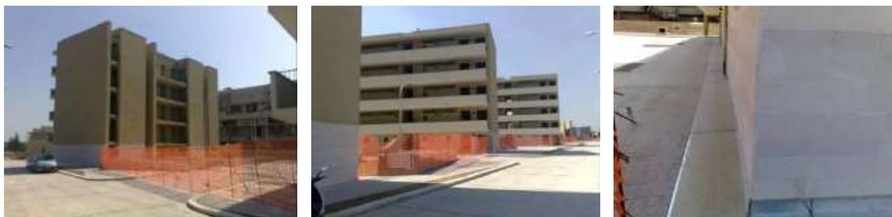
Figura 5 – Viste dei 4 edifici residenziali isolati sismicamente del nuovo Quartiere residenziale San Samuele di Cerignola (FG), in zona sismica 2, e (a destra) del lamierino di protezione del *gap* (collaudo in corso d'opera dell'autore di questa relazione, con rilascio del certificato di collaudo previsto nel 2008).
