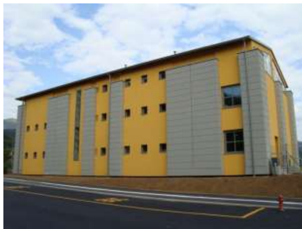
Figura 7 – La scuola di Galliciano (LU) di Figura 4, a costruzione ultimata
