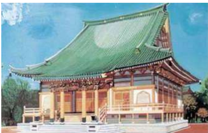
Figura 1 – Tempio buddista in legno pregiato di Jyourakuin , costruito a Tachikawa (in prossimità di Tokyo) su una base in cemento armato isolata con 20 dispositivi a ricircolo di sfere prodotti dalle aziende giapponesi THK e Aseismic Devices Co. , uniti a 3 coppie di due isolatori in gomma sovrapposti (con la sola funzione di ricentraggio) e ad un grande dissipatore in piombo (periodo d'isolamento superiore a 10 s e spostamento di progetto di circa 1 m) (11)
