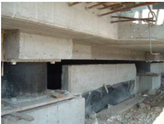
Figura 6 – Un isolatore elastomerico della corona esterna installato nella nuova scuola di Galliciano di Figura 4
