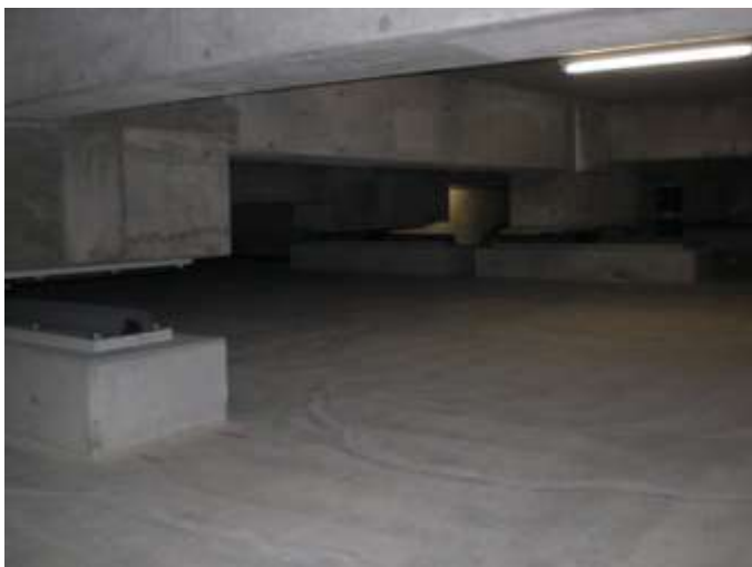
Figura 3 – Un isolatore a ricircolo di sfere del sistema di isolamento sismico del tempio di Figura 1
