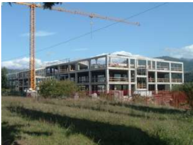
Figura 4 – Vista, durante la costruzione, della scuola elementare e media di Galliciano (LU), isolata sismicamente assieme ad altre 4 nuove scuole toscane nell'ambito delle attività previste dal Protocollo d'Intesa sull'isolamento sismico firmato nel 2004 dalla Regione Toscana, dall'ENEA e dal GLIS. La scuola di Galliciano è stata progettata con la collaborazione del socio onorario del GLIS e socio fondatore dell'ASSISi Prof. Mauro Dolce (ora Direttore dell'Ufficio Rischio Sismico e Post-Emergenza del Dipartimento della Protezione Civile) ed è stata collaudata dal Prof. Alberto Parducci dell'Università degli Studi e-Campus di Roma, membro del consiglio direttivo del GLIS e socio dell'ASSISi
