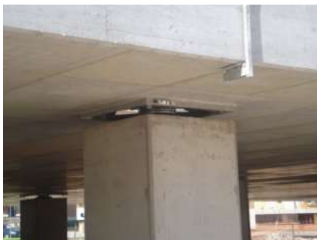
Figura 12 – Uno degli isolatori SIP realizzati dalla società ALGA, installati sotto le piastre di Figura 11
