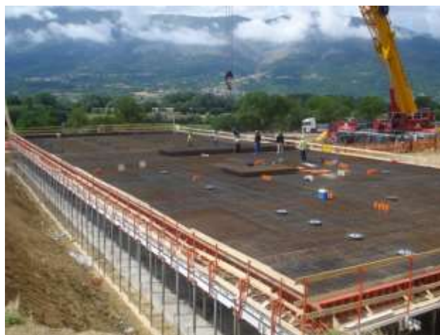
Figura 11 – Una delle oltre 184 piastre isolate simicamente realizzate nell'area de L'Aquila per sorreggere i prefabbricati realizzati nell'ambito del Progetto C.A.S.E.
