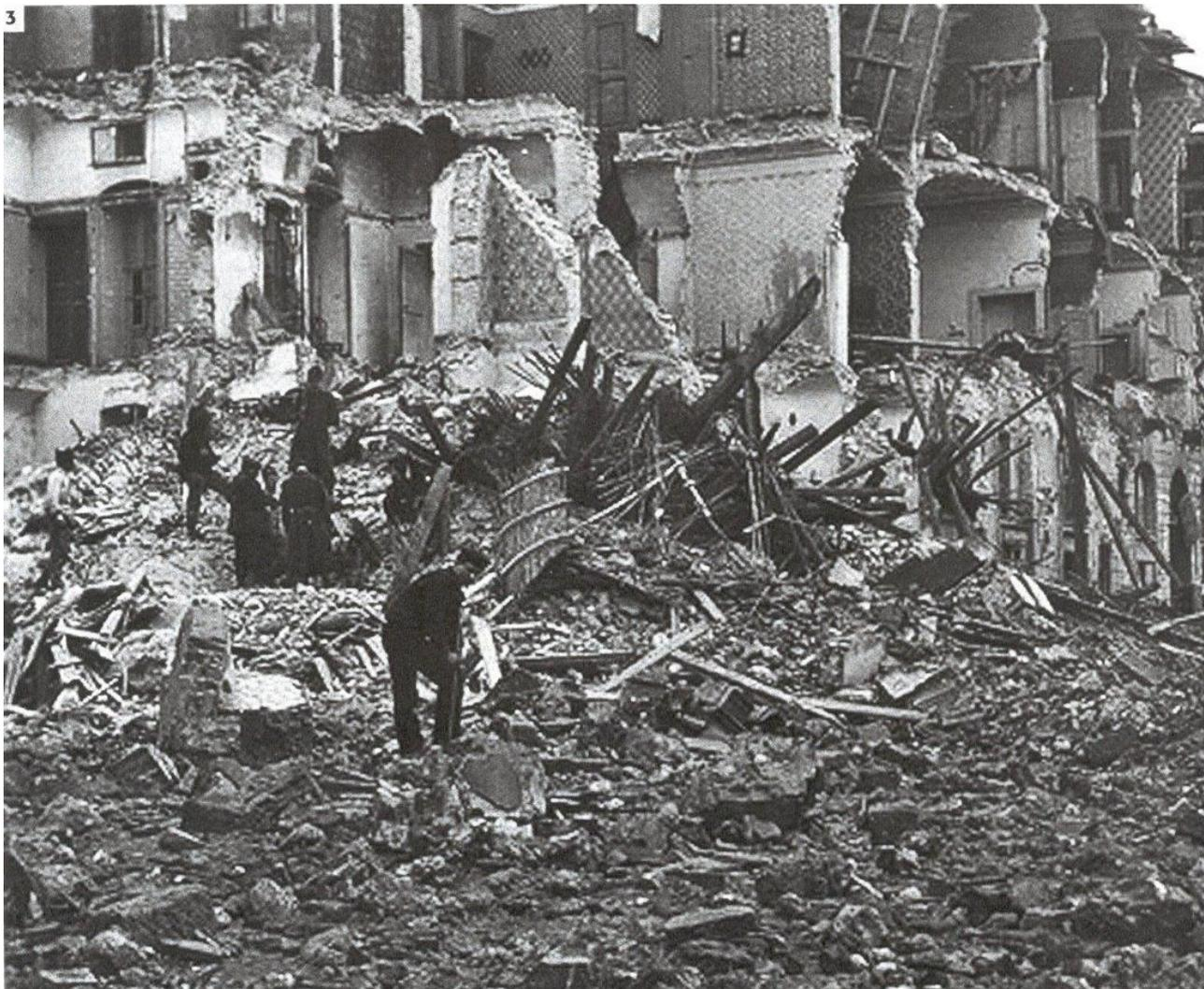
Figura 3: Crolli fuori dal proprio piano delle pareti di un edificio situato in Piazza Cavallotti (dalle Collezioni di RMS-Republic.com)
