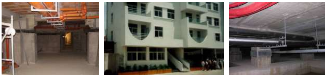
Figura 4: Vista del nuovo piano interrato della palazzina di Figura 3, con gli isolatori e le linee delle tubazioni già installati (a sinistra); palazzina residenziale isolata sismicamente con HDRB a Shantou nel 1994, prima applicazione cinese di moderni sistemi d'isolamento (al centro – si noti la scala d'accesso, vincolata alla sovrastruttura, ed il gap verticale che essa presenta rispetto al terreno circostante); vista, in luglio 2008, di alcuni degli HDRB della nuova scuola Francesco Jovine di San Giuliano di Puglia, e del Centro Professionale ed Universitario "Le Tre Torri", protetti dal possibile attacco di ratti mediante griglie labilmente collegate, in modo da non ostacolare la deformazione laterale durante un terremoto (a destra).
