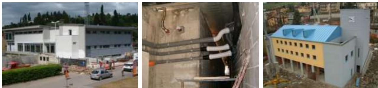
Figura 1: La sede dell’Associazione “Fratellanza Popolare – Croce d’Oro” di Grassano (a sinistra); le tubazioni di interfaccia del gas di tale edificio (al centro); la Sala Civica e sede della Croce Rossa di Gaggio Montano (a destra).
