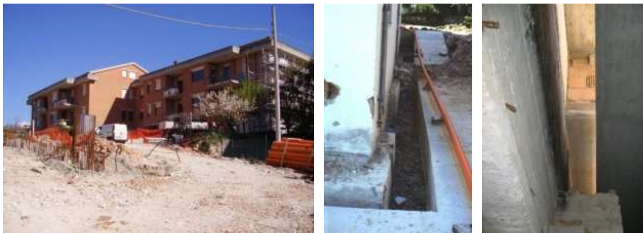
Figura 3: Palazzina di Via Fratelli Latini a Fabriano, adeguata sismicamente con l'isolamento sismico in sottofondazione (a sinistra); realizzazione del gap durante i lavori effettuati nel 2002 (al centro); vista dal basso (dall'interno del nuovo piano interrato) del gap realizzato, a lavori completati nel 2006 (a destra).
