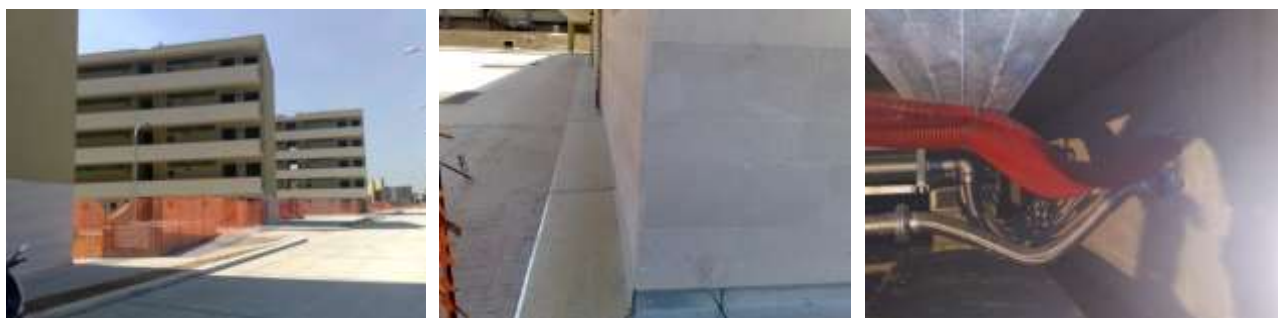
Figura 2: Vista dei 4 edifici residenziali isolati sismicamente del nuovo Quartiere San Samuele di Cerignola in agosto 2008 (a sinistra); piastre di protezione dei giunti strutturali mediante lamierini d’acciaio (al centro); giunti flessibili delle tubazioni d’interfaccia contenenti fluidi non pericolosi (a destra).
