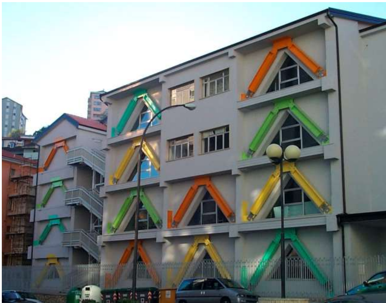
Figura 4 – Scuola Domiziano Viola di Potenza – Esempio di applicazione della dissipazione d'energia (dissipatori elastoplastici)
