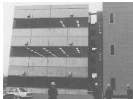
Laboratorio della Matsumura Corporation 3 piani superficie di calpestio di 480 m2 Isolatori: 4HDRB d70 h13,5+4HDRB d60 h13,7
