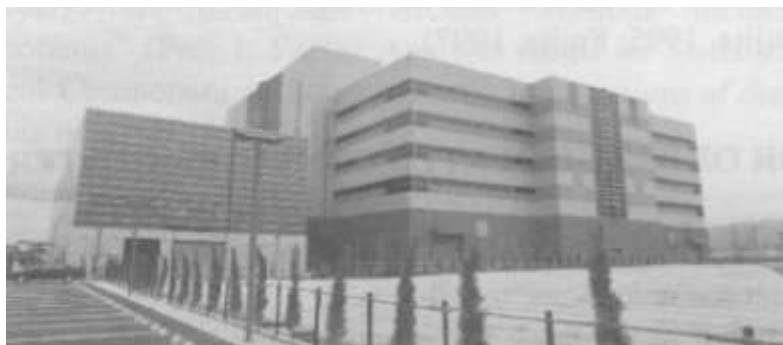
Computer center del Ministero delle Poste e Telecomunicazioni 6 piani superficie di calpestio di 46.823 m2, allora il più grande edificio isolato al mondo. Isolatori: 54 LRB d120h24 +46 Low Damping natural rubber d100 h20 20 Low Damping natural rubber d80 h16+44 steel damper
